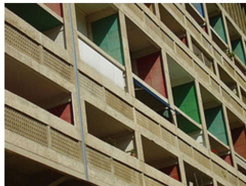
Unité d'Habitation, Le Corbusier, Marseille, 1947-52
