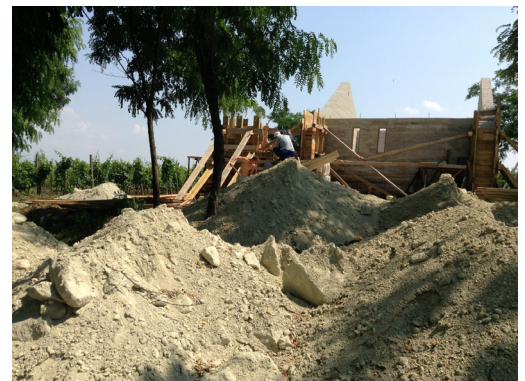
288 tufa 'hulladék' építés közben, 2013
