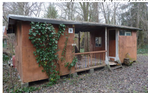
Horány, Meteor telep építményei, 2009
