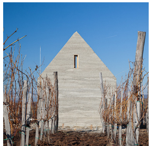
289 a készülő kunyhó tufa kőbeton fala, 2014
