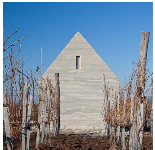
12 a készülő kunyhó tufa kőbeton fala, 2014
