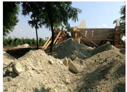
11 tufa 'hulladék' építés közben, 2013
