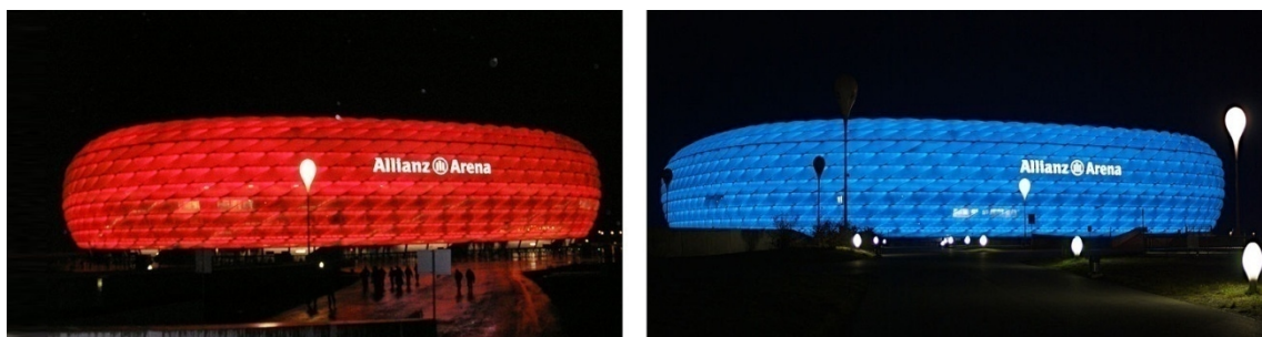
Egy stadion, két csapat, két szín. Az Allianz Aréna különleges homlokzata, Herzog & de Meuron, 2005 30,31
