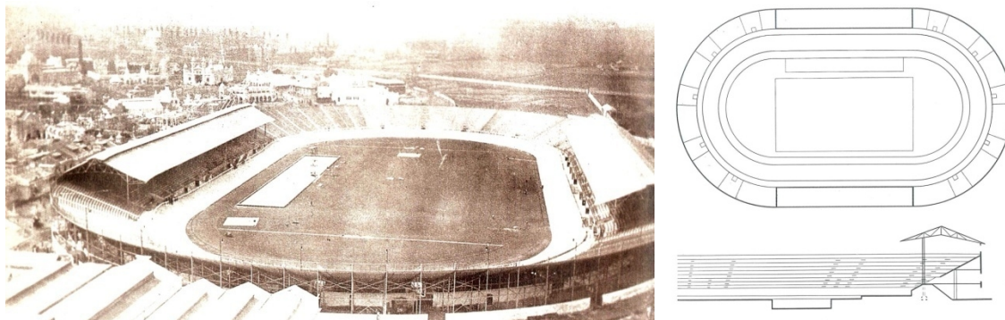
A londoni White City stadion, látképe, alaprajza és jellemző metszete, J. J. Webster, 1908 39, 40
