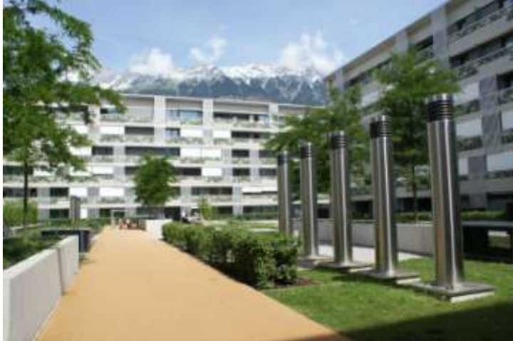
Passívház-lakótelep sportolóknak Lodenareal, Innsbruck, Ausztria, 2011 Tervezők: architekturwerkstatt din a4 & team k2 architekten Foto: Székér László, 2011
