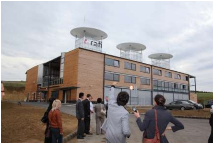
Energiadesign ipari csarnok RATI centrum Komló Tervezők: Kistelegdi István és ifj. Kistelegdi István, 2012 Forrás: Építészfórum, Pásztor Erika
