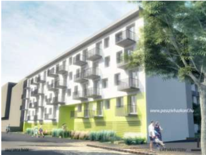
LEED Platinum minősítéssel Modellfoto az épületről 100 lakásos passzív ház projekt Budapest XIII, Tervező: Nagy Csaba, 2013 Forrás: Tervezők, passzív házak és energiahatékony épületek konferencia 2012, tervező előadása
