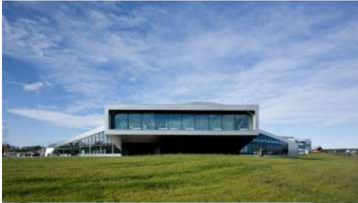
Inspiria Science Center Gaalum, Norvégia Tervezők: AART Architects A/S (Aarhus, Dánia) , 2011 Forrás: PPA, tervezők
