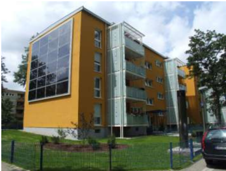
Paneles mélyrekonstrukció, Németország, Ludwigshafen Tervező: LUWOGÉ Consult, 2007 Foto: Székér László, 2008
