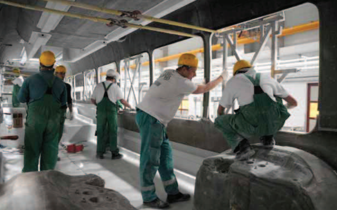
77. ábra, Távtartó keretek behelyezése
