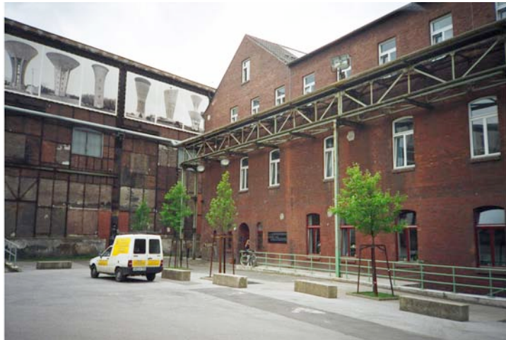
21 / Diák szálló fogadóépülete, Landschaftpark Duisburg Nord (Emscher program 1990 -)
