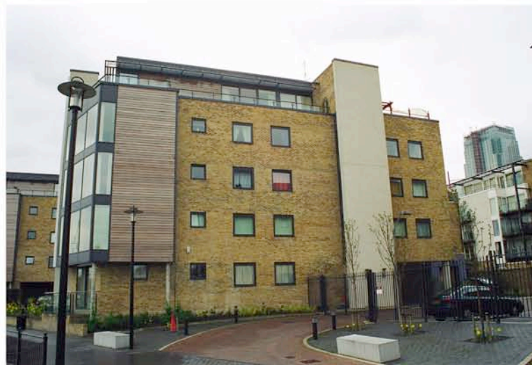
20 / Dockland London 2003- Új építésű lakóházak a régi épülettömegre utaló formaképzéssel, anyaghasználattal
