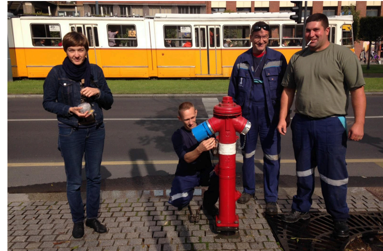
Az első Ivócsap széria felszerelése a Fővárosi Vízművek munkatársaival, 2014. szeptember, Budapest, fotó: Ivócsap Projekt
