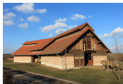
38. kép balra: lóistálló felülnézete; 39-40. képek középen és jobbra: jellemző nézetei; lóistálló, Mende, Reischl Gábor, 1995 Az épület alapkarakterét befolyásoló tört tető a gerinc felnyitással, egyben a természetes szellőzés megoldásának építészeti eszköze.
