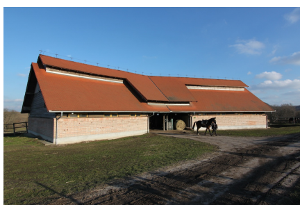
38. kép balra: lóistálló felülnézete; 39-40. képek középen és jobbra: jellemző nézetei; lóistálló, Mende, Reischl Gábor, 1995 Az épület alapkarakterét befolyásoló tört tető a gerinc felnyitással, egyben a természetes szellőzés megoldásának építészeti eszköze.
