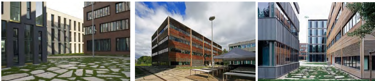
10/ UPV, Unterföhring Park Village, München, Németország (1999-2010)
