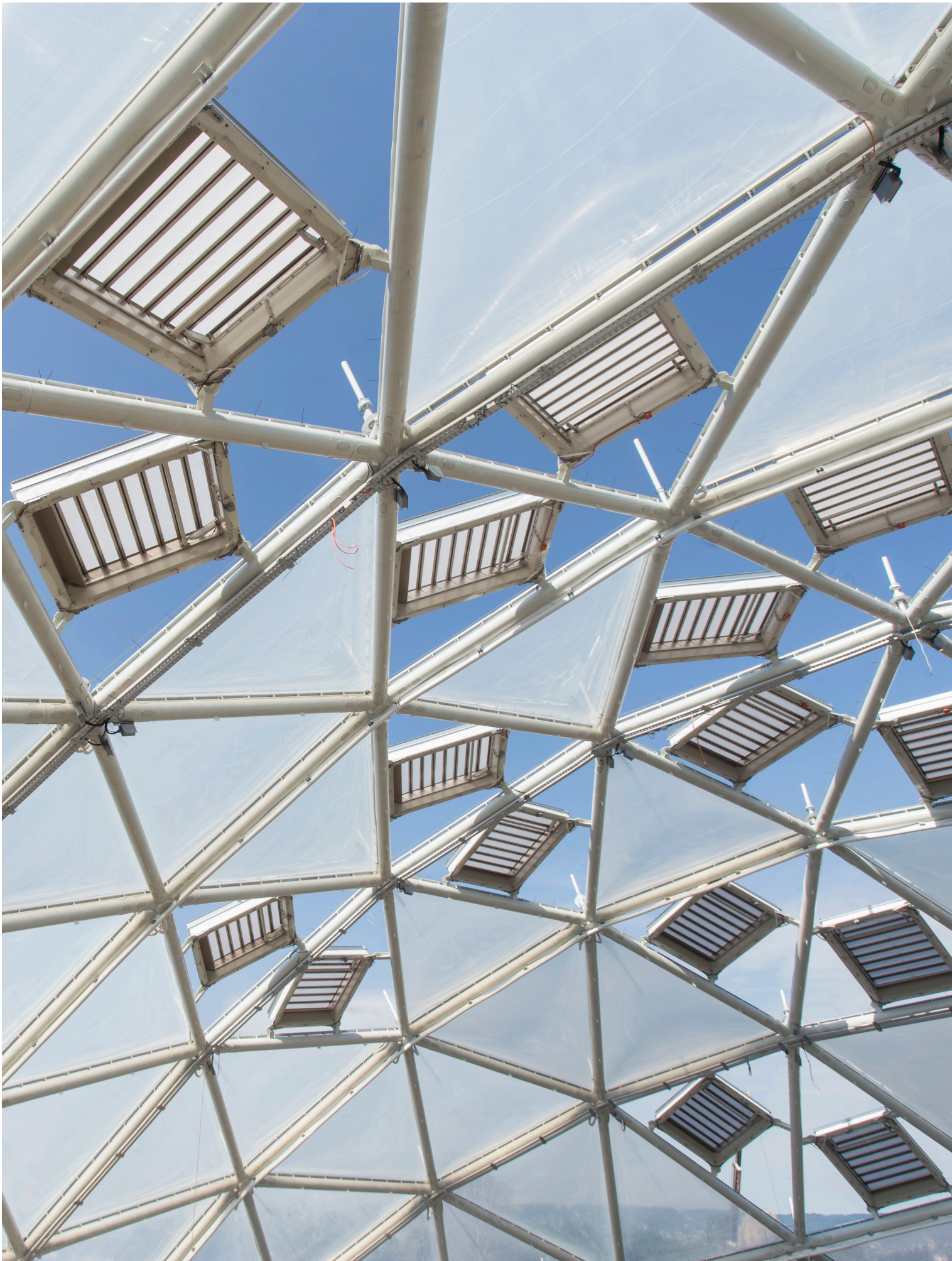
Pannon Park Biodóm, a Fővárosi Állat- és Növénykert bővítése, Budapest, 2014-2020., Generál építészeti tervező: Mérték Építészeti Stúdió Kft. Fotó: Csizik Balázs
