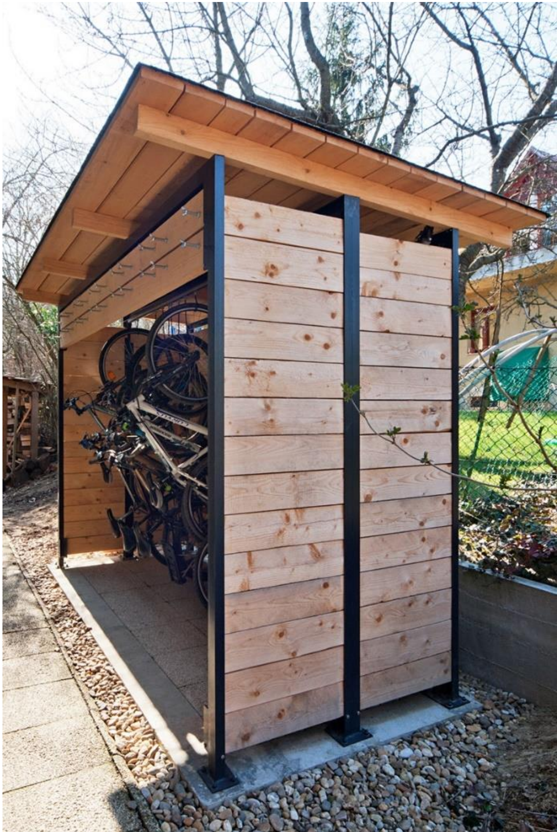
47. ábra: Kerékpártároló Solymáron. Kép I. Fotó: Bujnovszky Tamás
