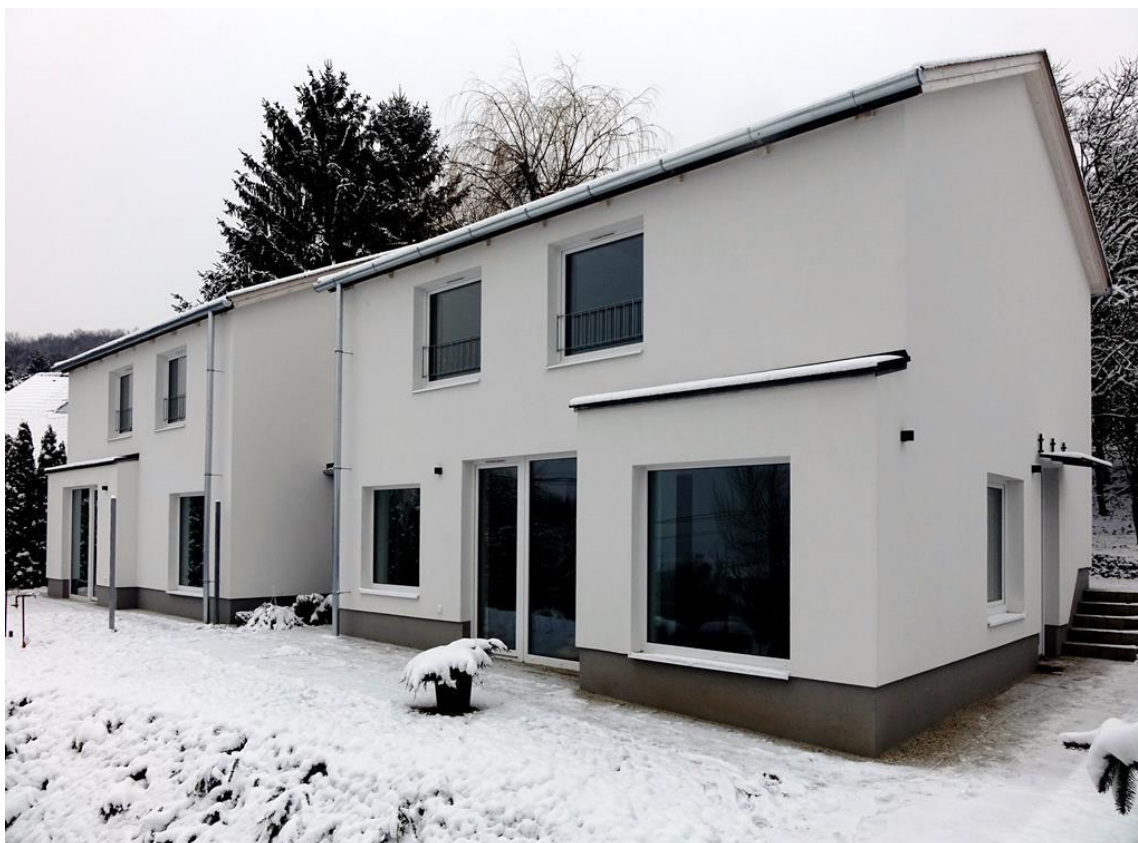
65. ábra: Kétlakásos társasház Solymáron, Kép II. Fotó: Kőrösi Péter
