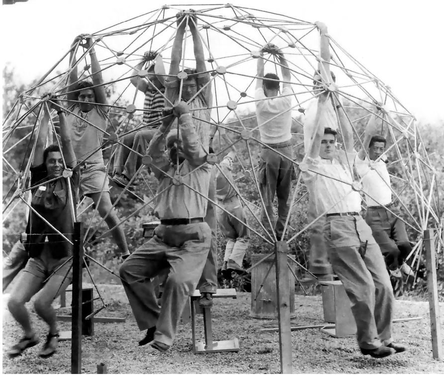
24. Buckminster Fuller építész osztályával teszteli tensegrity elvét alkalmazó, öntartó, geodézikus dómszerkezetét a Black Mountain Collegeben 1949 nyarán
