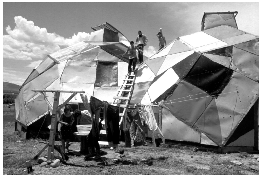
38. A Drop City lakói a Colorado állambeli Trinidadban saját építésű, Buckminster Fuller geodézikus dómszerkezeteit, újrashasznosított autómotorháztetők felhasználásával újraértelmezett Zome ok mellett.
