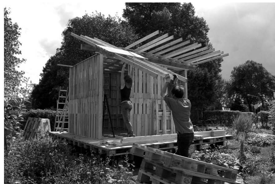
54. Raklap-ház Holstenkamp, építés közben Studio Experimentelles Design, 2013–14
