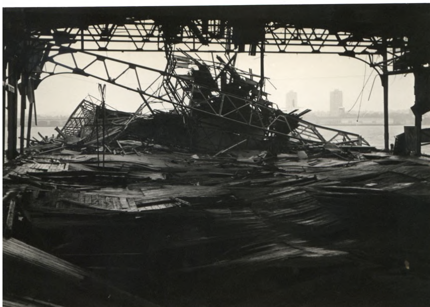
Alvin Baltrop: Collapsed (Összedőlt) , West Side Piers, New York, 1975-1986
